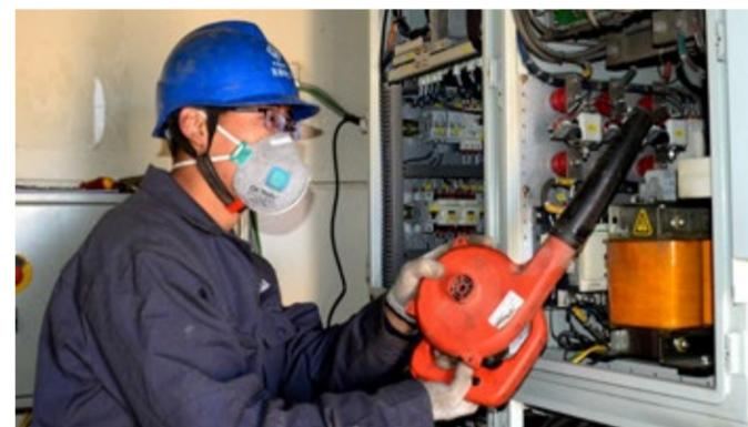
为进一步加强风电机组运行状态管理，及时发现并消除隐患缺陷，确保风电机组安全稳定运行，2018年3月22日，龙源河北公司东湾风电场运检人员在清洁维护风机变频器。
